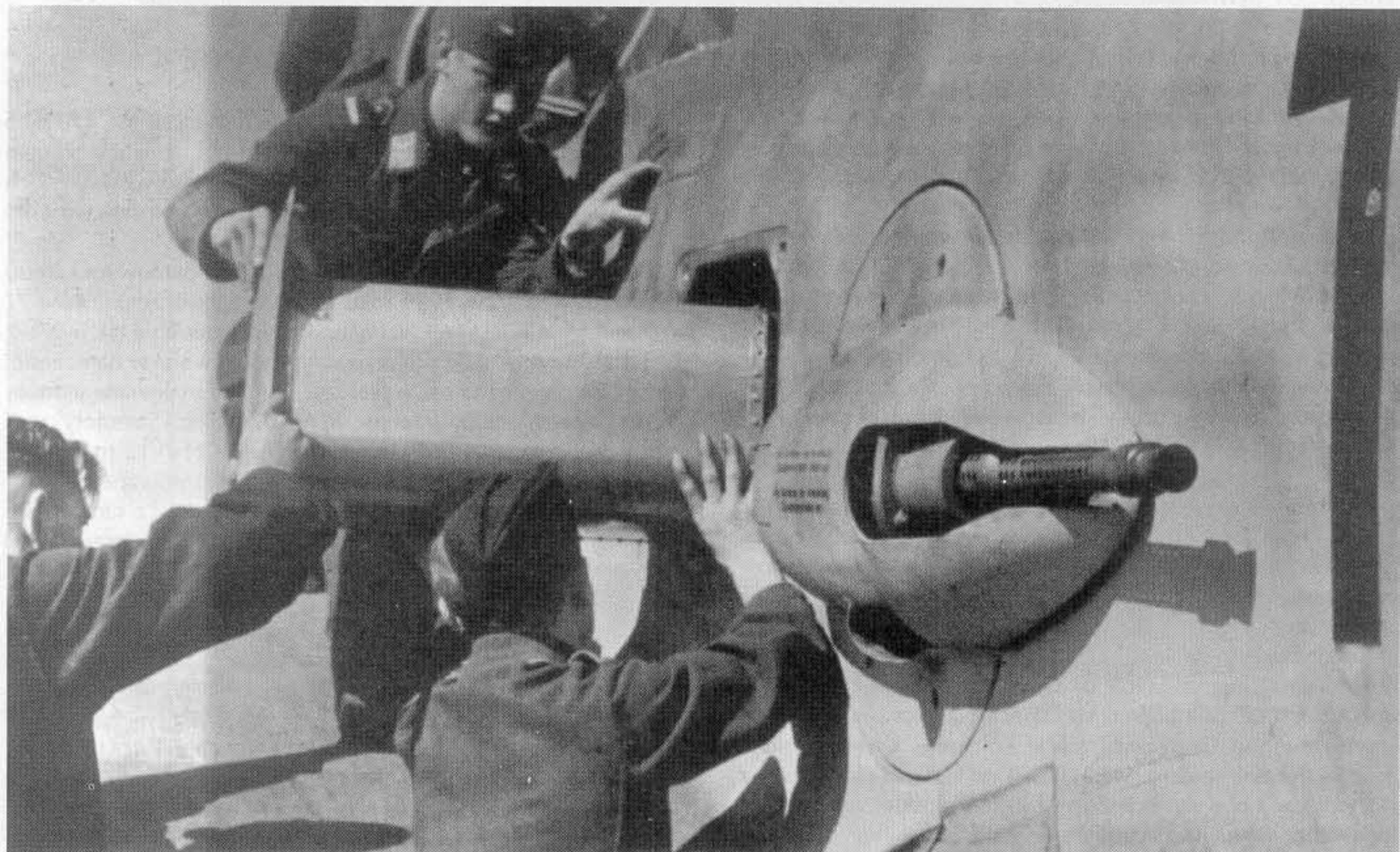
Załadunek zasobnika z amunicją do karabinu maszynowego MG 131 (FSDL 131), samolot Me 410B-1 TE+EQ z Stab/ 3. Jagd Division, Le Mans, Francja, 1944 rok. Ground crew loading ammo into FDSL 131 lateral gun barbettes, Me 410B-1 TE+EQ of the Stab/3. Jagd Division, Le Mans, France, 1944 [Aero Pictorials]
